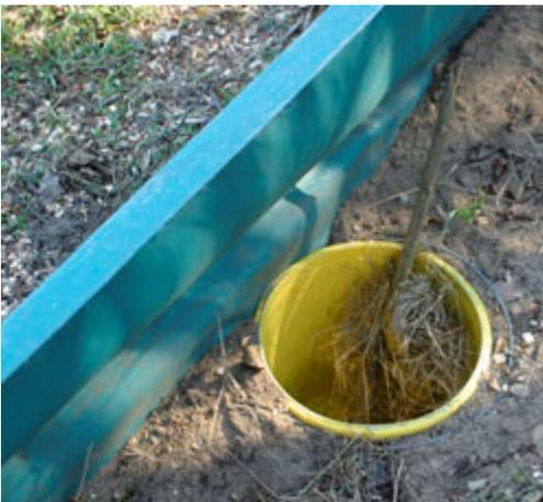
Das Loch wird vor der Folie ausgehoben. Ratsam ist es, an der Stelle die Erde von der Folie zu nehmen und die Folie etwas nach hinten zu schieben.
